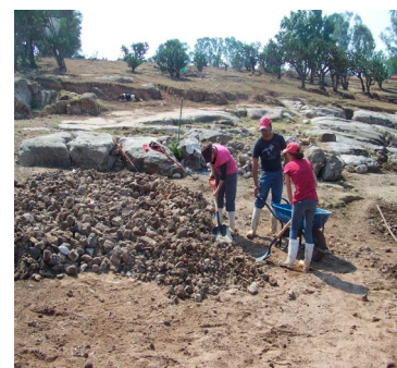
Fotografía 2. Limpieza de la presa: rocas.
