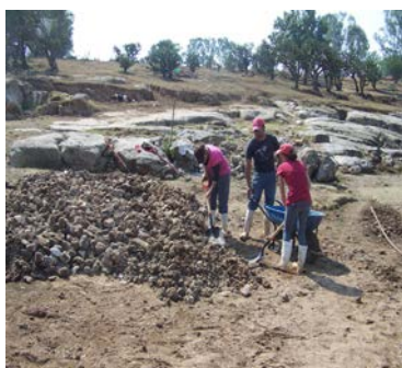
Fotografía 2. Limpieza de la presa: rocas.
