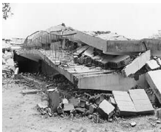
Fig. 6. Colapso del colegio Valentín Valiente en Cariaco, 1997
