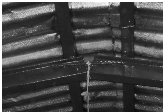
Fig. 10. Detalle de la unión central del techo de la U.E. Las Quebraditas
