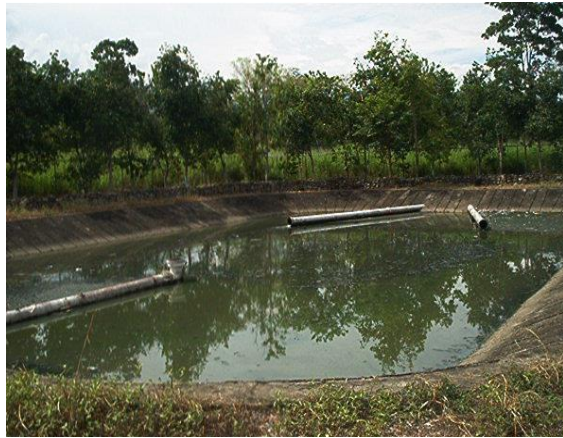
Fig. 2. Laguna Facultativa de 20m X 30 m, vista aguas arriba, implementada en Caño Seco, Municipio Alberto Adriani, Zona Panamericana del Estado Mérida. Foto: Espinosa, Carlos
