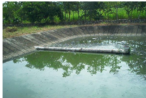
Fig. 18. Laguna Facultativa de 20 m x 30 m, implementada en Caño Seco, Municipio Alberto Adriani, Zona Panamericana del Estado Mérida. Observación en campo de la zona de estancamiento localizada en el extremo derecho aguas abajo.
