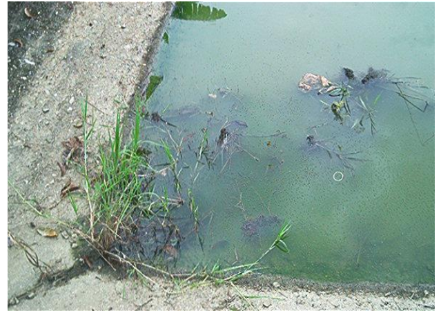
Fig. 36. Laguna Facultativa de 25 m x 50 m , implementada en Caño Amarillo, Municipio Alberto Adriani, Zona Panamericana del Estado Mérida. Observación en campo de la zona de estancamiento en el extremo derecho aguas abajo. Foto: Espinosa, Carlos
