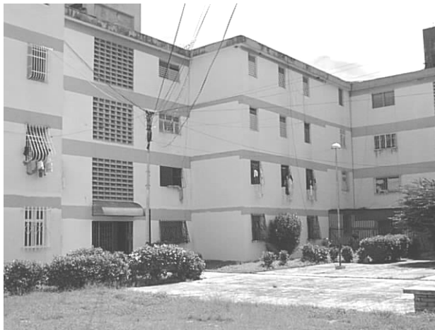
Fig. 4. Edificios en contacto parcial.
