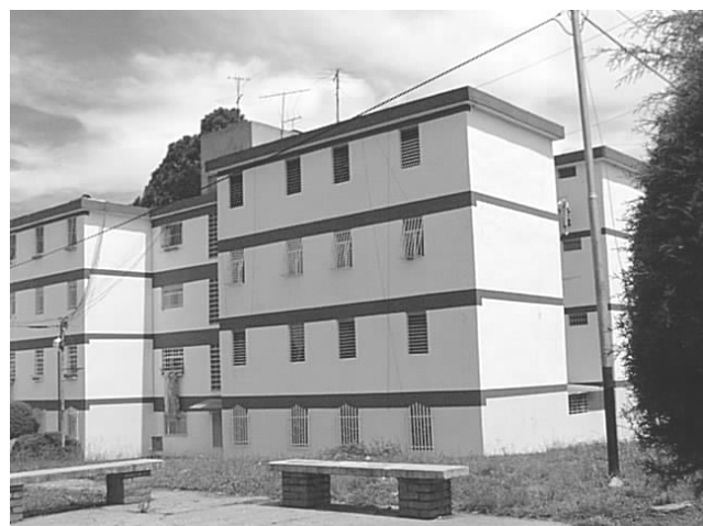
Fig. 3. Edificios con la planta baja construida.
