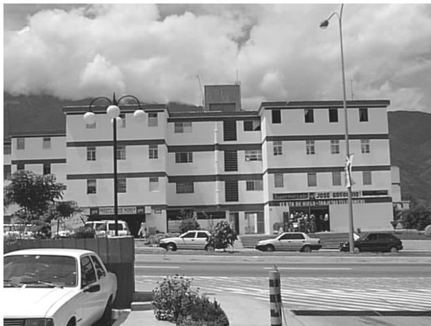
Fig. 5. Edificio en estudio.
