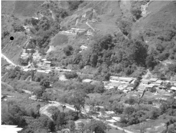
Anexo N° 7: Ubicación de viviendas en el sector de alto riesgo
