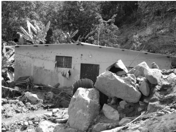
Anexo N° 4: Desalojo de viviendas afectadas.
