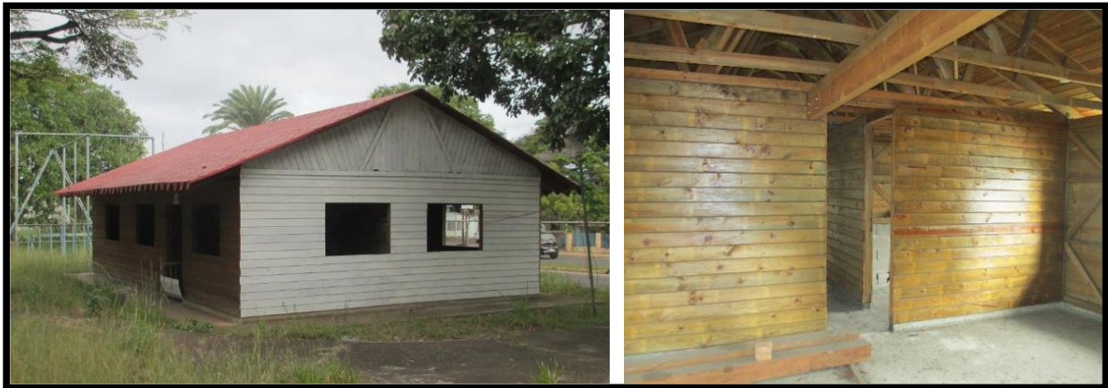
FIGURA 5. Prototipo de vivienda social construido en madera de pino Caribe de la Orinoquia realizado en Upata, Venezuela. Se empleó un sistema constructivo mixto de paneles entramados auto-portantes, como soporte de las cerchas/armaduras y viga laminada central sobre losa de hormigón. Foto: Wilver Contreras Miranda
