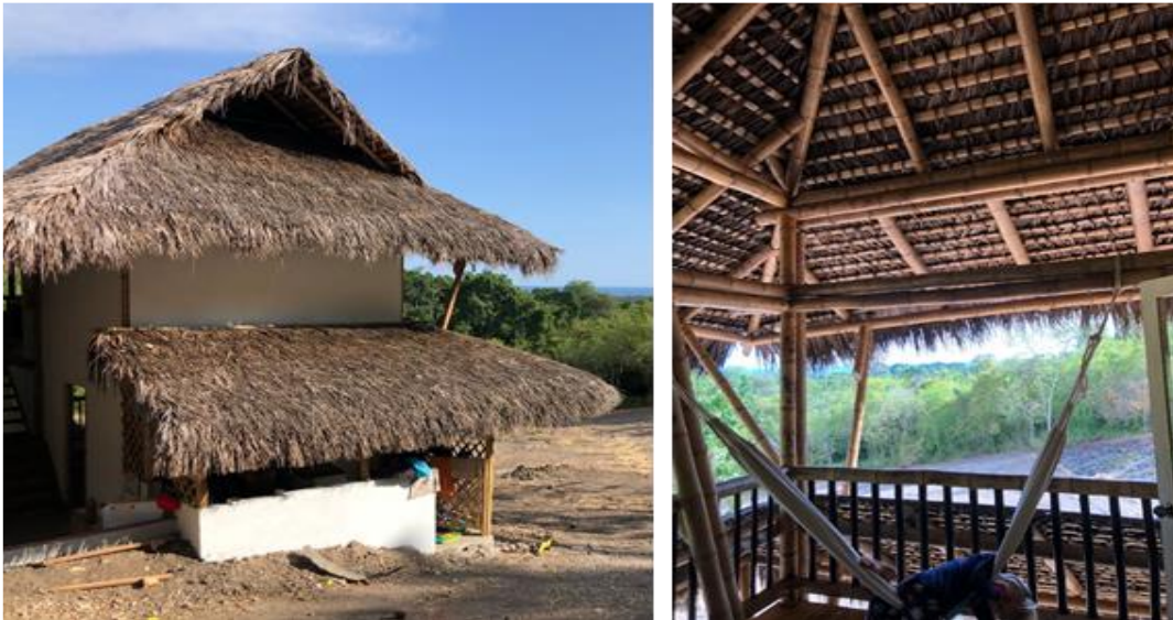
FIGURA 6. Vivienda tradicional localizada en área rural de Ayampe, Ecuador; construida en bambú y techumbre de palma con algunos cerramientos de mampostería de bloques y friso de cemento-cal, sobre losa corrida de hormigón. Fotos: Axel A. Contreras Owen.
