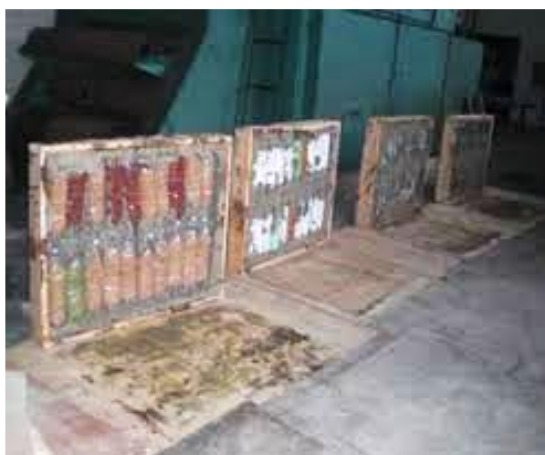
FIGURA 12. Formaleta con el vaciado de la mezcla sobre las botellas. Contreras Owen et al. (2012).
