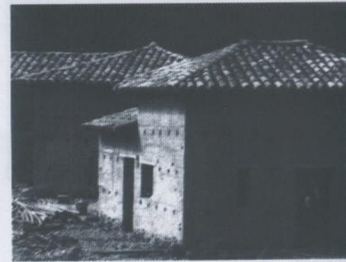
El Centro de Conservación, construido bajo el sistema tradicional del tapial.
