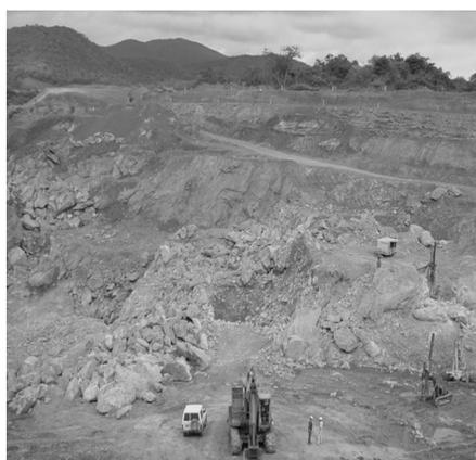
Figura 4: Explotación en yacimiento de saprolita y veta. Revermin-Crystallex
