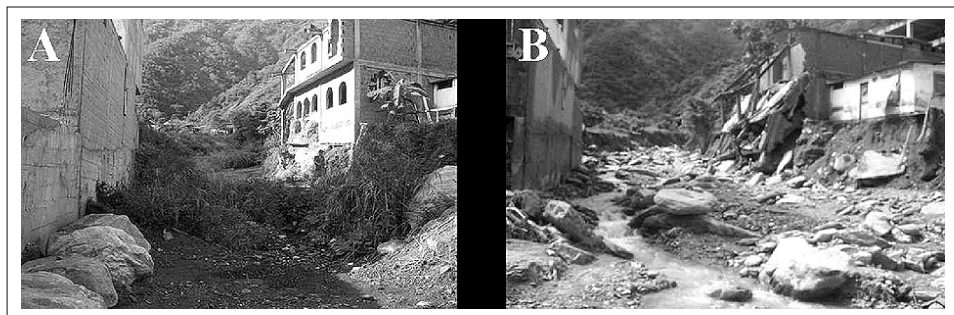
Figura 13. En el recuadro A se observa el estado del barrio Quebrada Seca (Caraballeda), en octubre de 2004, tal como se hallaba años después de los aludes de 1999. Es notorio el paso del cauce entre las casas, por donde antes se encontraba una calle. En el recuadro B se aprecian las consecuencias de las lluvias de febrero de 2005 y el agua corriendo por su cauce nuevamente. Fotografías y composición: Rogelio Altez
