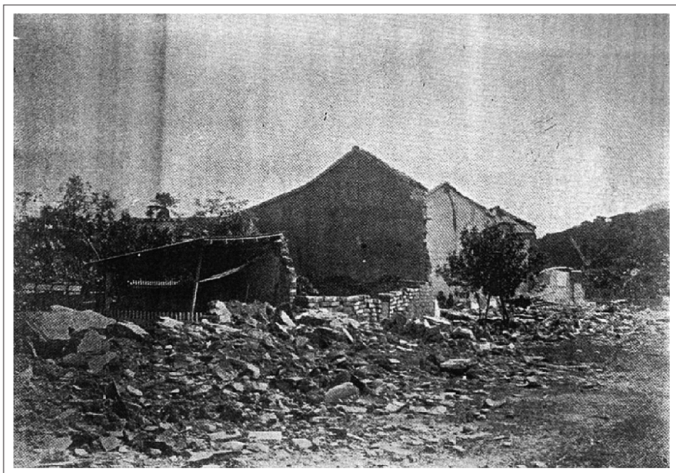
Figura 7. Fotografía de los daños sufridos por La Guzmania, Macuto, con el terremoto de 1900. Tomada de El Cojo Ilustrado
