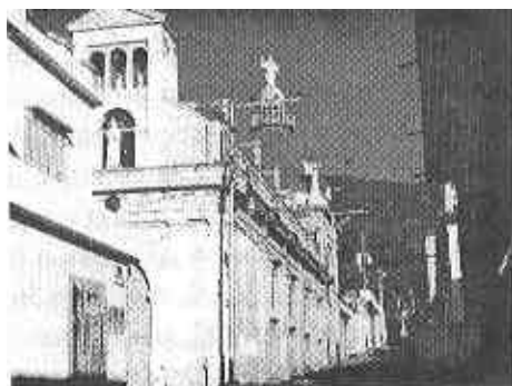
Figura 9. Vista anterior a la rehabilitación
