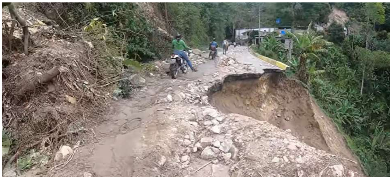
FIGURA 7. Vialidad afectada entre el sector El Amparo y Zea, agosto 2021
