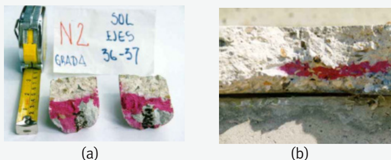
Figura 7. Perfiles de concreto carbonatado en núcleos extraídos(a) y gradas en sitio (b)
